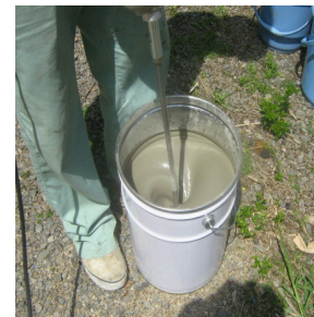
モルタルの攪拌状況
