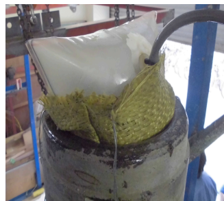
繊維シートの圧着
