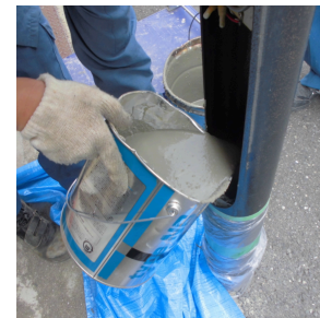
モルタル充填作業
