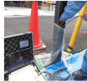
支柱内の調査
