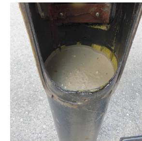
支柱内の充填状況
