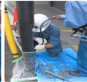
支柱内の錆除去
