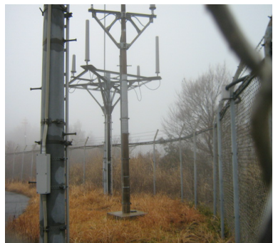
岩国送信空中線柱補修工事を受注 (平成23年 国土交通省大阪航空局発注)
